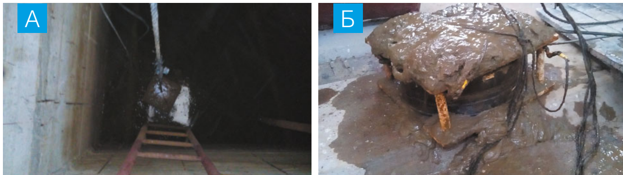
Рис. 2. Водоприемный колодец с гидроакустическим излучателем и глинисто-иловой смесью на его верхней крышке: а) общий вид; б) детальный вид
