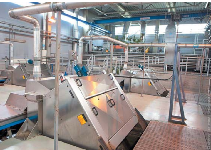
Рис. 4. РЕШЕТКИ В ОТДЕЛЕНИИ МЕХАНИЧЕСКОЙ ОЧИСТКИ
