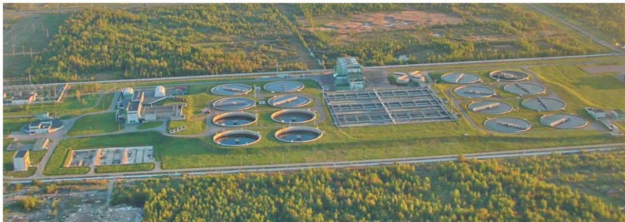
Рис. 2. Общий вид станции. Движение сточных вод – слева направо. Четыре опорожненные радиальные емкости на переднем плане – усреднители расхода
