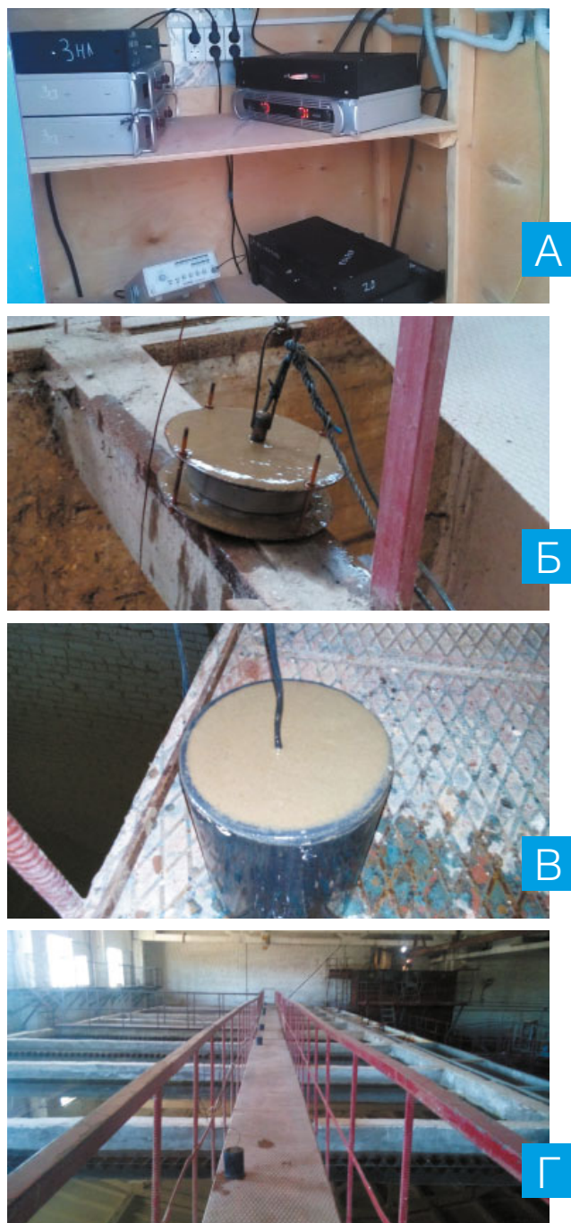
Рис. 3. Внешний вид усилителей мощности и гидроакустических излучателей: а) цифровые усилители мощности; б) низкочастотный излучатель ЦГИ-ШНЧ в термощкафу в водоприемном колодце; в) высокочастотный излучатель; г) высокочастотные излучатели ЦГИ-ШВЧ в блоке осветителей
